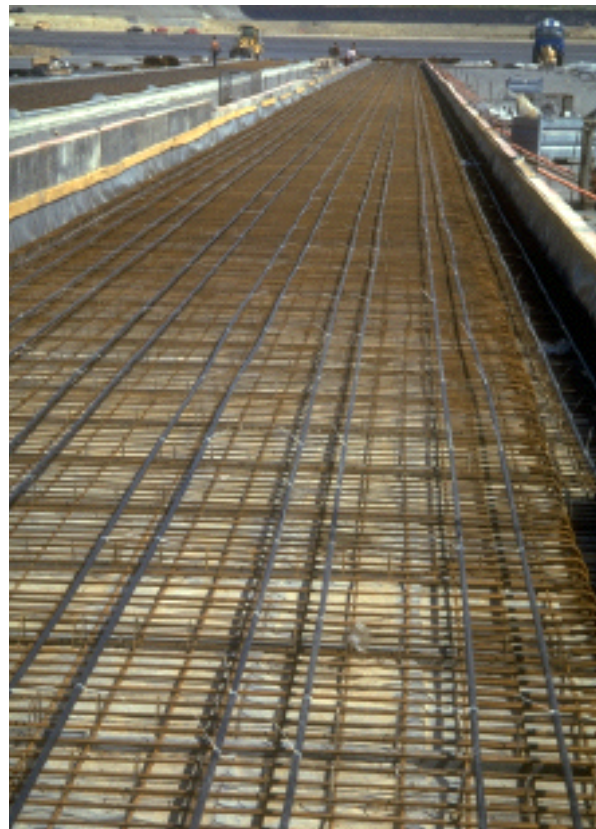
Bild 13: Vorgespannte Bodenplatte der Beckenkonstruktion
