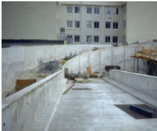
Bild 10: Rampenkonstruktion für Autowaschanlage
