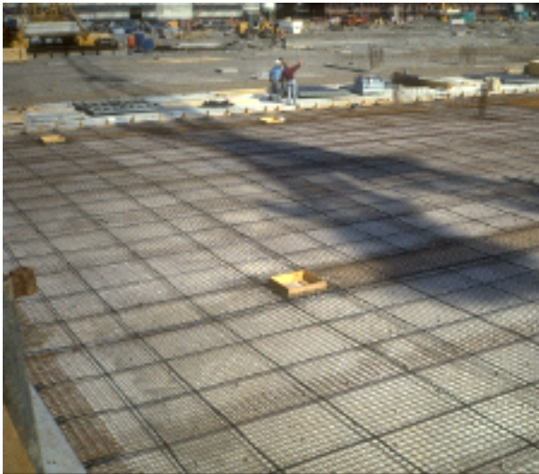
Bild 4: Vorspannung für eine Bodenplatte
