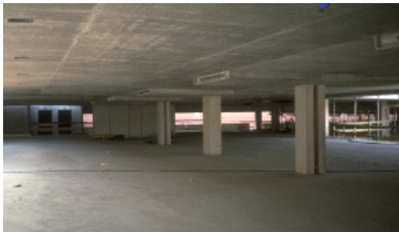
Bild 7: Betonplatte für Parkfläche
