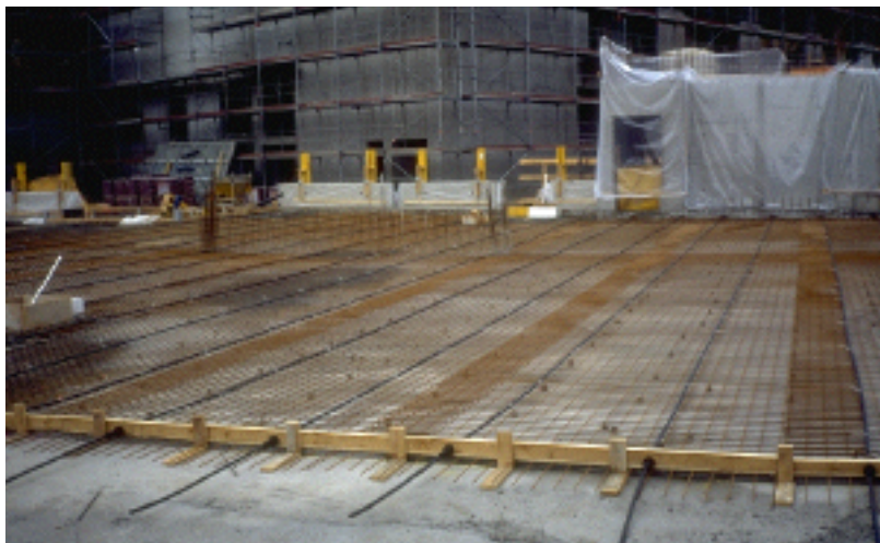
Bild 5: Abschnittsweises Vorspannen
