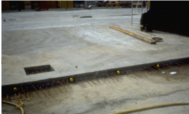
Bild 6: Fertiger Bauabschnitt einer Bodenplatte mit Arbeitsfuge
