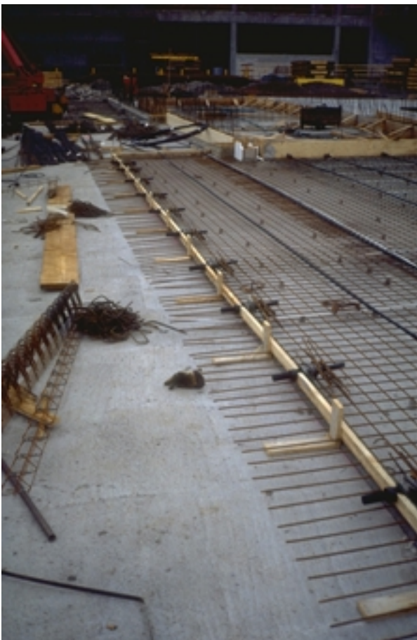
Bild 8: Spannanker an der Abschnittsgrenze
