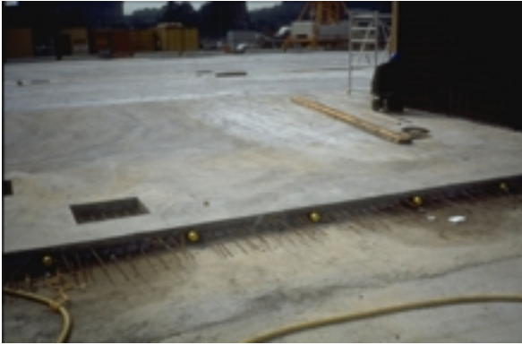
Bild 6: Abschalung mit Verankerungen für einen Bauabschnitt
