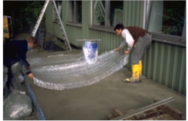
Bild 11: Einbau eines AR-Glasfasernetzes in der obersten Deckschicht
