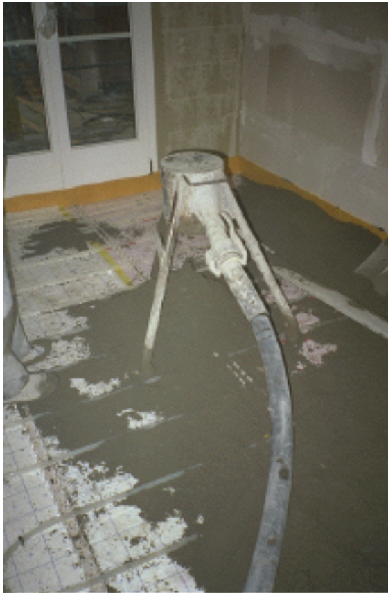
Bild 13: Einbau von erdfeuchtem Estrich
