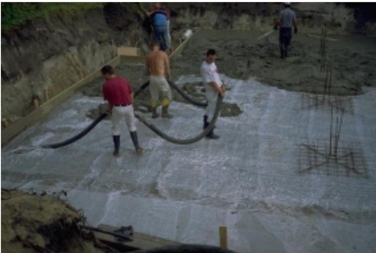
Bild 8: Bodenplatte von Wohnhäuser: untere textile Bewehrung ausgelegt
