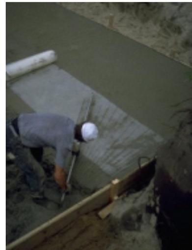
Bild 9: Bodenplatte von Wohnhäuser: Einarbeiten der oberen textilen Bewehrung
