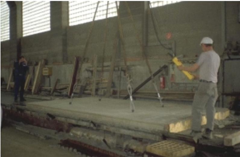
Bild 7: Montagezustand: Abheben der Platte aus der Schalung
