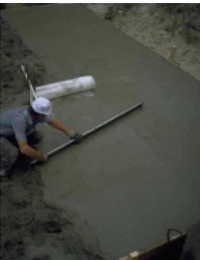
Bild 6: Einarbeiten der textilen Bewehrung mit einer Glättbohle
