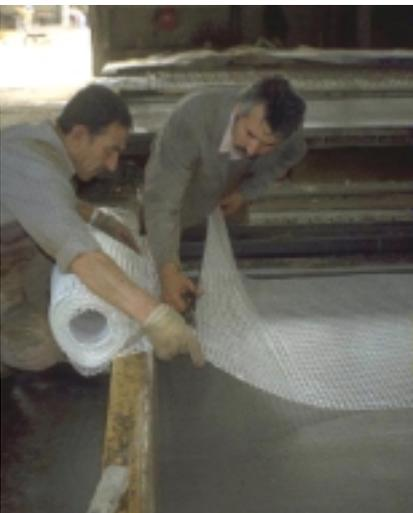
Bild 5: Textile Bewehrung direkt auf die Schalung verlegt
