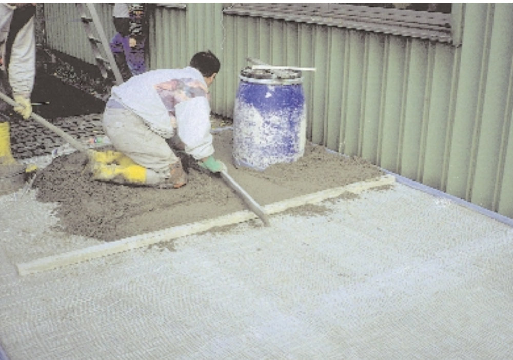
Bild 10: Dichtfläche mit Glasfasergitter
