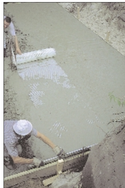
Bild 9: Bodenplatte: Einarbeiten der oberen Glasfasergitterbewehrung.
