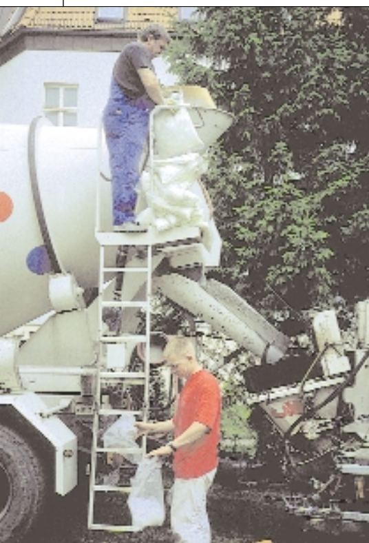
Bild 2: Einmischen der alkaliresistenten Glasfasern in den Transportbetonmischer.
