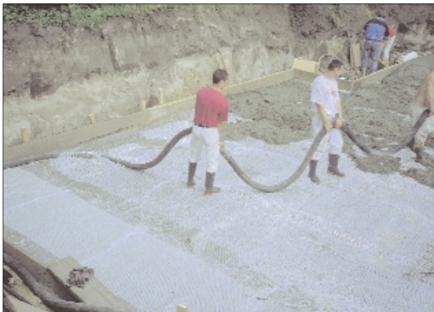
Bild 8: Bodenplatte: Betonieren auf die untere Glasfasergitterlage.
