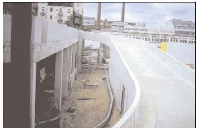
Fugenlose Betonplatte: Rampenbauwerk
