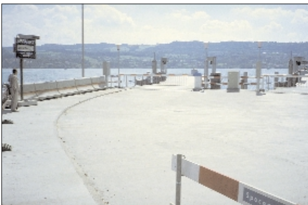
Fugenloser Betonbelag: Anlegestelle
