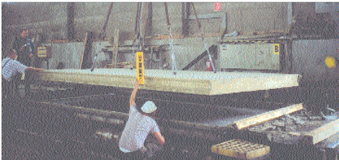
Abb. 15: Beanspruchungen der Platte durch den Montagezustand
