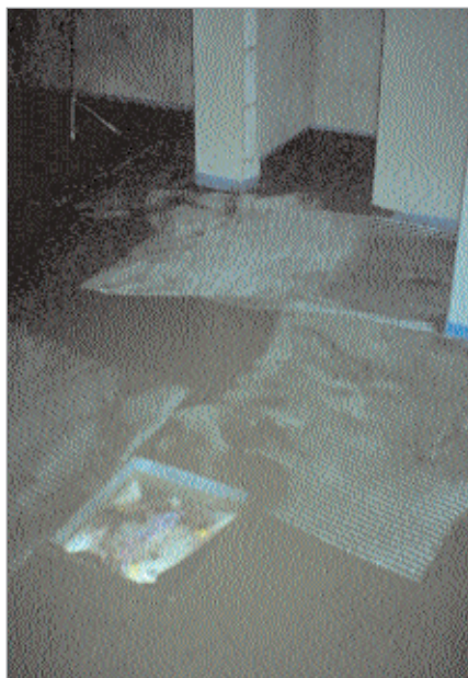
Abb. 10: Zementfließestrich mit Boden-einlauf – Verstärkung mit Gelege
