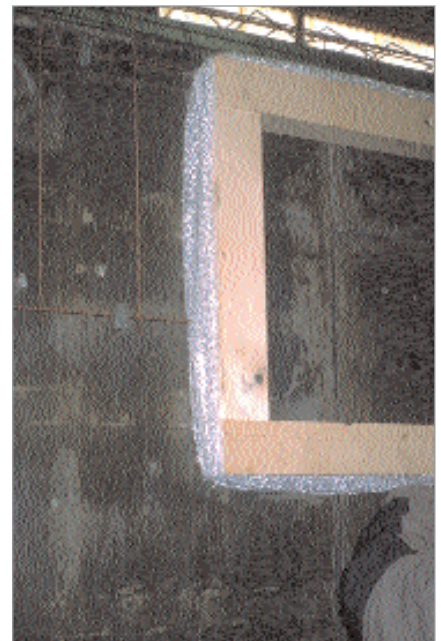
Abb. 8: Bandage aus textiler Bewehrung entlang einer Wandöffnung
