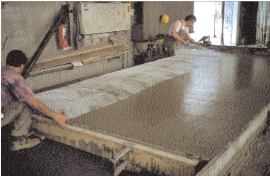
Abb. 16: Auslegen der textilen Bewehrung auf der frischen Betonoberfläche
