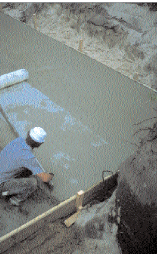
Abb. 17: Einarbeiten der oberen textilen Bewehrung mittels einer Glättbohle
