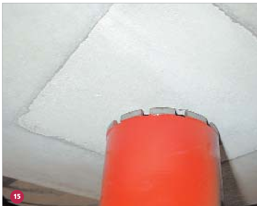
Gezielte Bohrung für Installation
