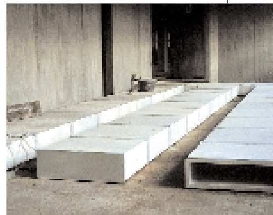
Bild 7: Gedämmte Lüftungskanäle aus Glasfaserbeton
