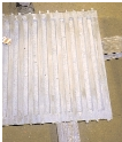
Bild 11: Strukturierte Plattenoberfläche mit bewehrten Verstärkungsrippen
