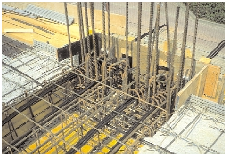
Bild 14: Randelement als integriertes Schalung bei Elementplatten
