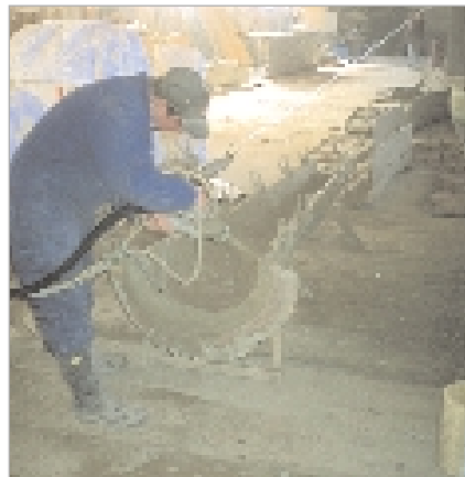
Bild 2: Manuelles Spritzen von Glasfaserbeton in eine dreidimensionale Schalung
