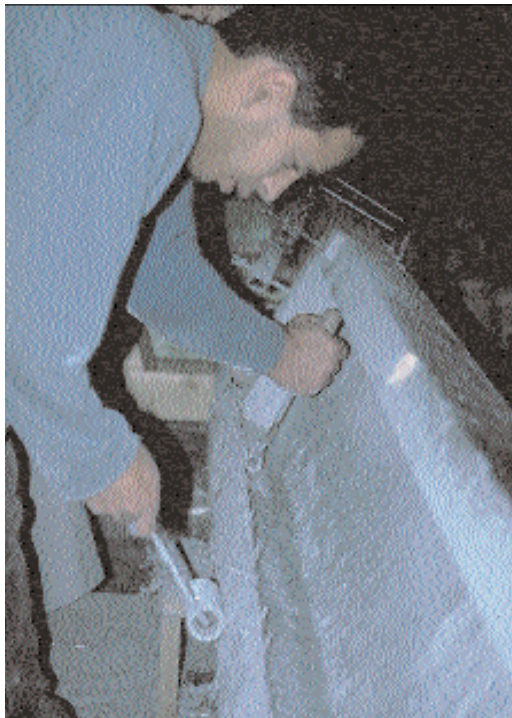
Bild 5: Manuelle Technik: Verdichten der Matrix mit Glasfasern
