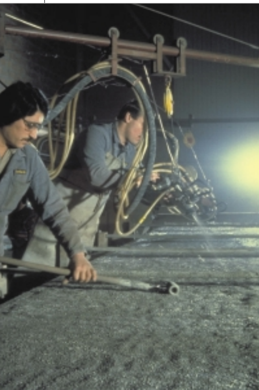
Bild 2: Auftragen der Schicht aus Glasfasern und Feinbeton und Verdichten
