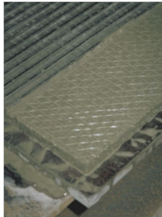
Bild 12: Verstärkung durch oberflächennahe Textilbewehrung
