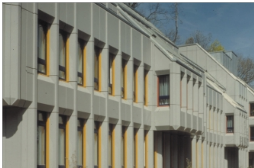
Bild 7: Fassadenstruktur aus geformten GFB-Elementen
