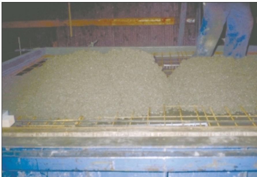
Bild 10: Zäher Beton mit AR-Glasfasern
