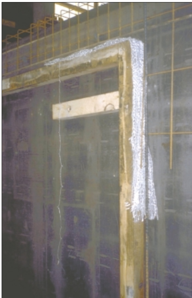
Bild 8: Textile Bewehrung aus AR-Glasfasern an einspringenden Ecken
