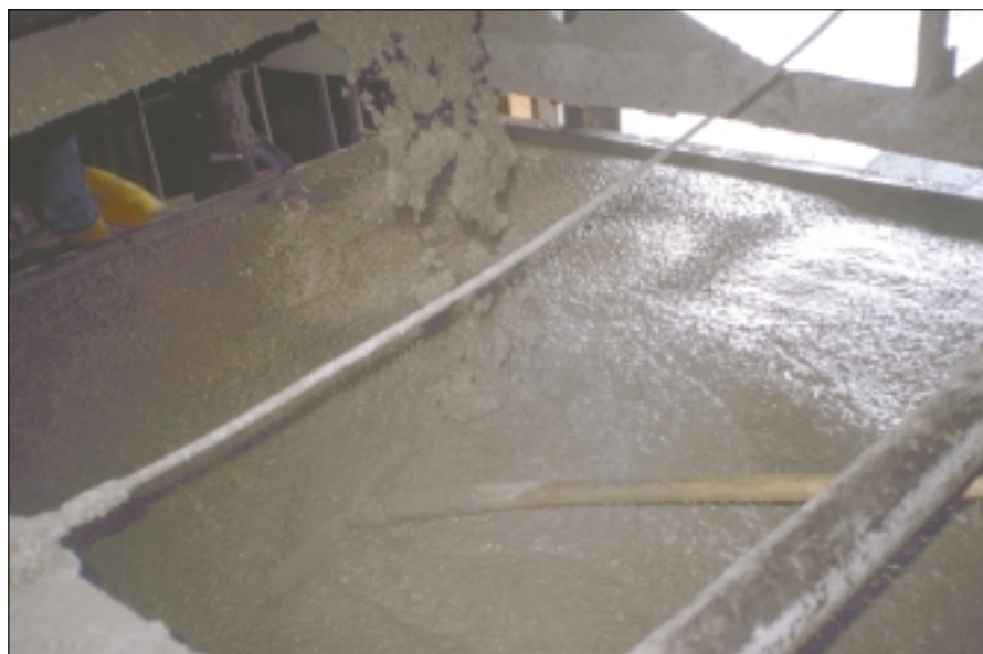
Bild 11: Thixotropes Verhalten eines fasermodifizierten Betons
