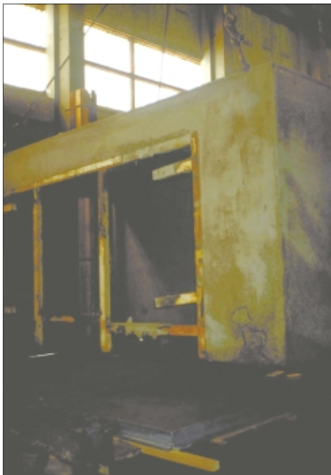
Bild 14: Betonfaserbewehrte Fertiggarage während des Transportes
