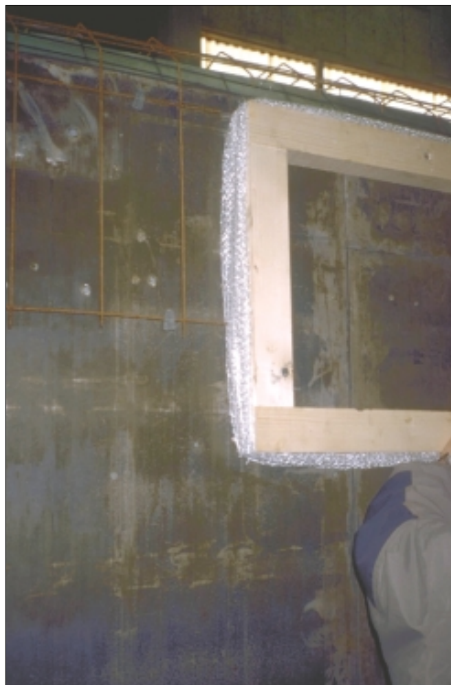
Bild 7: Bandagenbewehrung aus AR-Glasfasergitter
