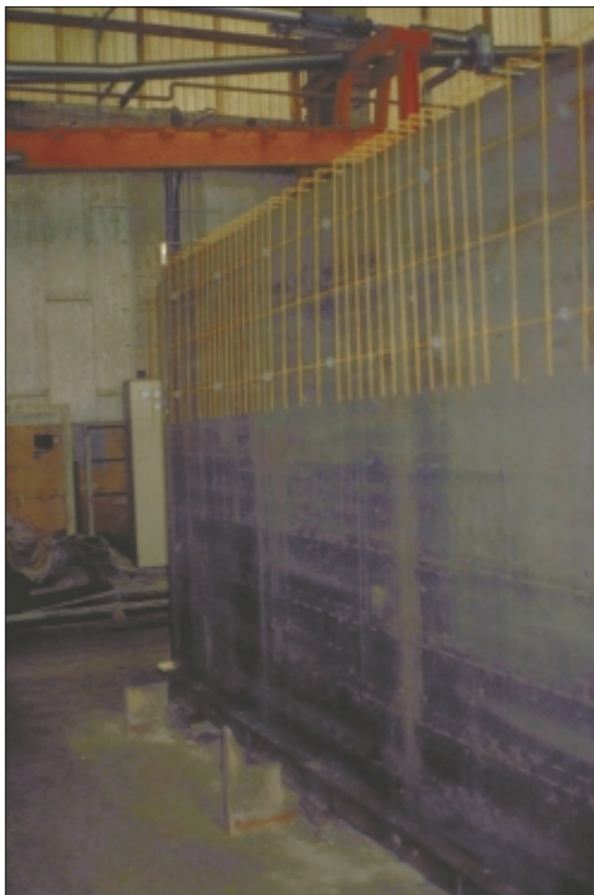
Bild 6: Deckenbewehrung und bewehrungsfreie Wand
