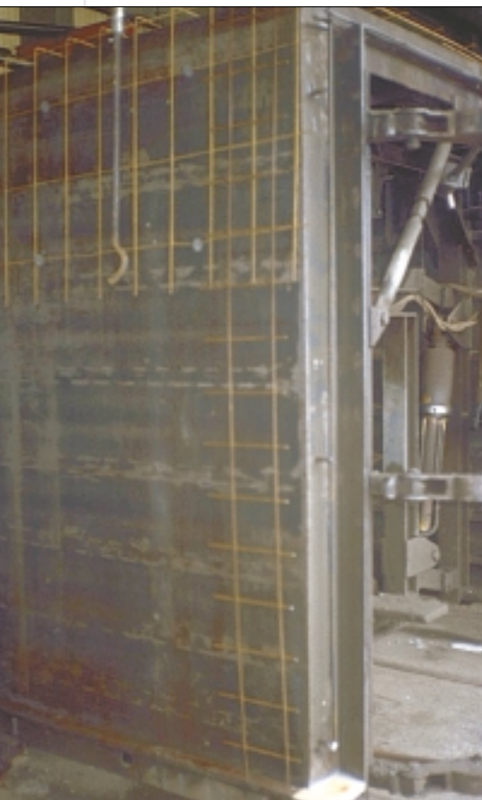
Bild 5: Restliche Stahlbewehrung für die Fertiggarage mit Betonfasern aus AR-Glas
