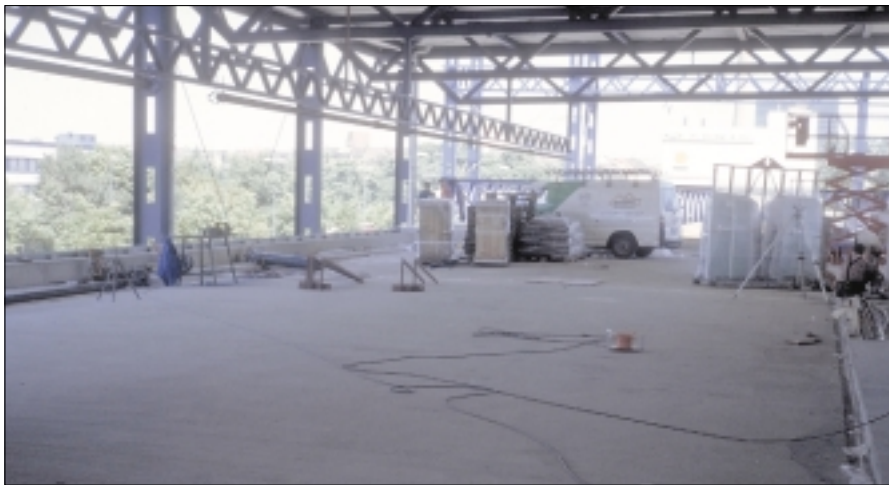
Bild 9: Fugenlose Lastverteilplatte auf Dämmschicht
