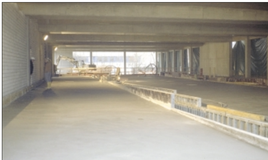
Bild 7: Fugenlose Bodenplatte mit Einbauten
