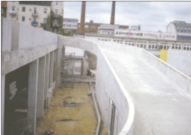
Bild 10: Fugenloses Ram- penbauwerk
