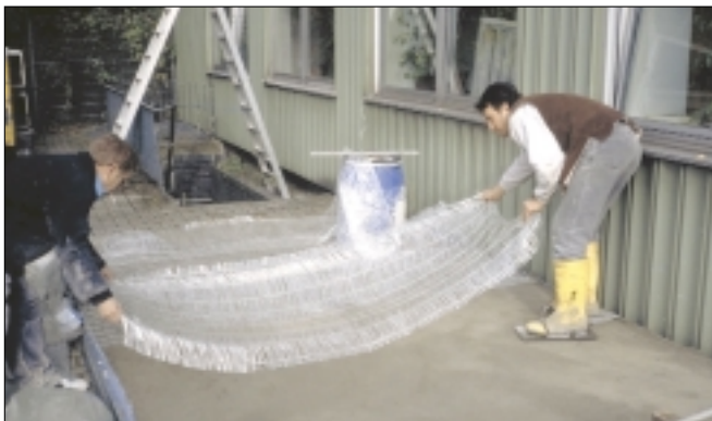
Bild 12: Textile Bewehrung für eine Dichtfläche
