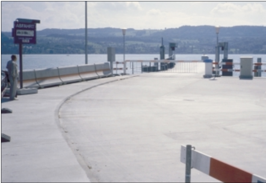
Bild 4: Plattform eines Anlegestegs für eine Autofähre
