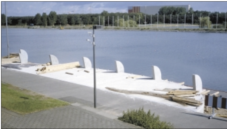
Bild 11: Plattform eines Bootsanlegesteges
